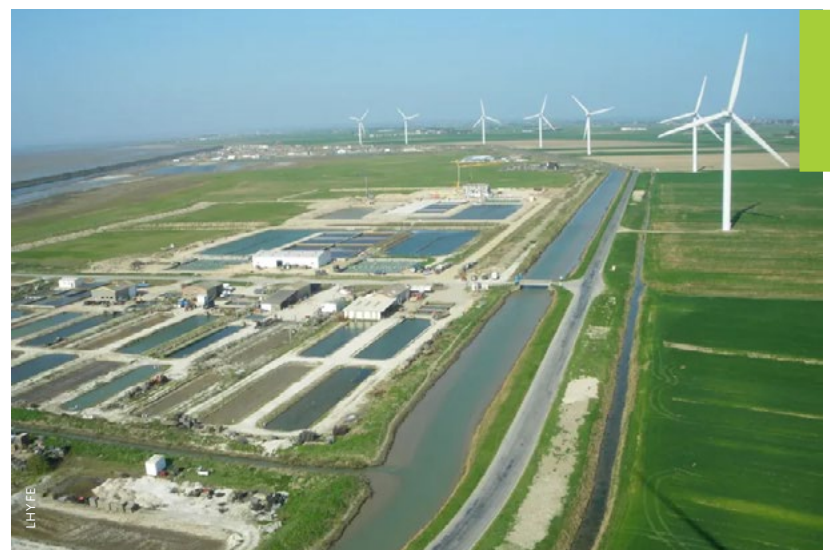
Site de production d'hydrogène par électrolyse de la start-up Lhyfe qui devrait entrer en service fin septembre 2021 et fournir à terme jusqu'à une tonne d'hydrogène vert par jour au pied du parc éolien de Bouin (Vendée).
